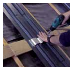
3 Pose des pattes de fixation doubles
