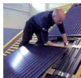
6 Pose des modules
