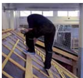
1 Mise en place des planches support
