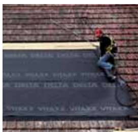
2 Mise en place de l'écran de sous-toiture
