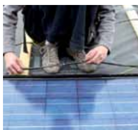
4 Pose des modules et raccordement
