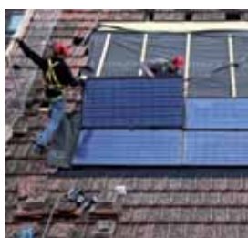
5 Installation de tous les modules
