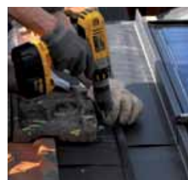
6 Pose des abergements et raccord couverture
