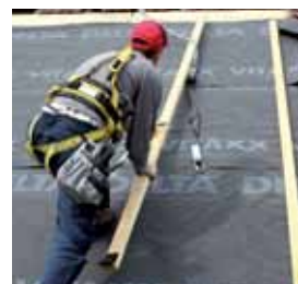
3 Positionnement des chevrons de modules
